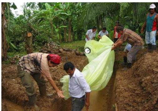
Fotografía 12. Instalación de biodigestor.
