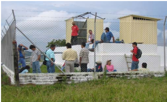
Fotografía 5. Tanque de almacenamiento acueducto
